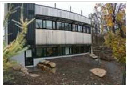
Le revêtement extérieur est fabriqué de poteaux de téléphone en cèdre qui ont été récupérés. Photos: JQM
