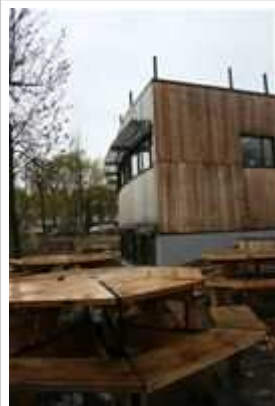
Le pare-soleil gardera la maison fraîche en été et chaude en hiver.
